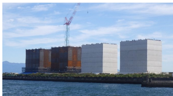
ケーソン製作現場
