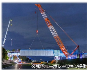
歩道橋 夜間設置工事の様子
