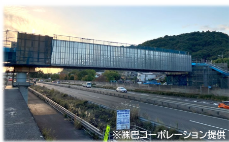
歩道橋設置後の様子
