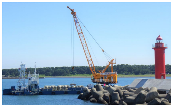
外港防波堤 被覆ブロックの設置(R6.9)
