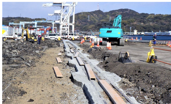
袖師岸壁 舗装版破碎後(R7.1)
