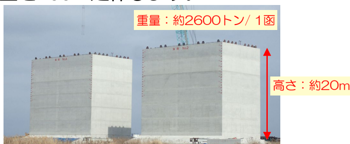
新興津岸壁延伸部に据え付けるケーソン（R7.3）
