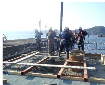
【下田港防波堤東上部工事】
