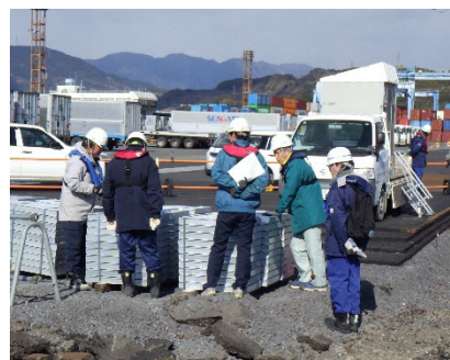
【清水港袖師地区岸壁改良工事】
