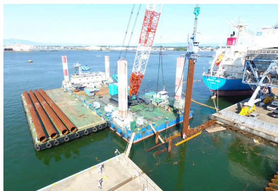
作業船による鋼管矢板打設状況
