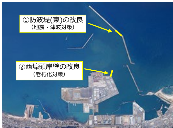
<御前崎港の事業箇所>
