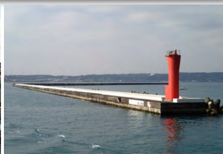
防波堤(西) 上部工の高上げ後 (2018年1月)
