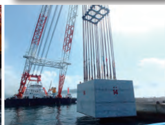
防波堤開口部（航路部）の方塊据付作業 (2016年7月)
