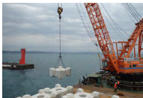
防波堤(西) 30t型被覆ブロックの据付作業 (2016年2月)
