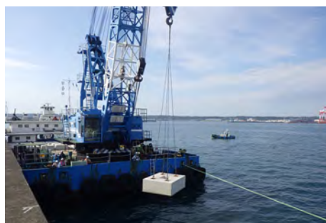
防波堤(東) 根固ブロックの据付作業 (2018年11月)
