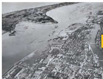
修築工事中の清水港 (1924年)
