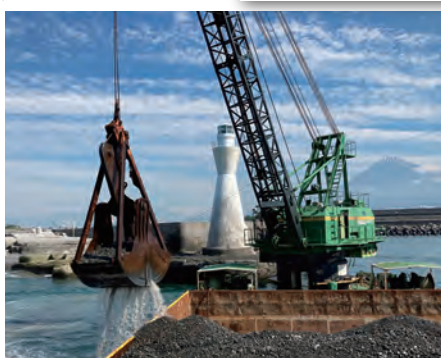
ポケットの掘削作業 （2021年5月）
