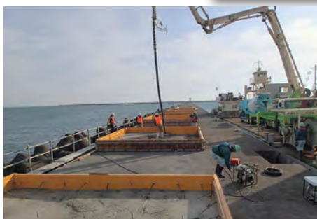
防波堤(西) 上部工の高上げ工事 (2017年11月)
