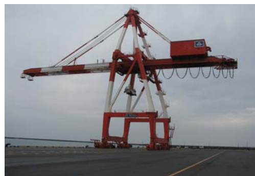
実証実験を行なった1号機
