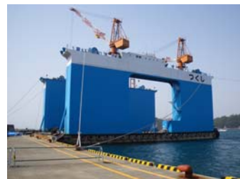
フローティングドック「つくし」 最大7,000tまでのケーソンが製作できます。
