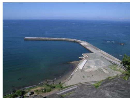
松崎新港(特定地域振興需要港湾) 2バース目の岸壁を整備中
