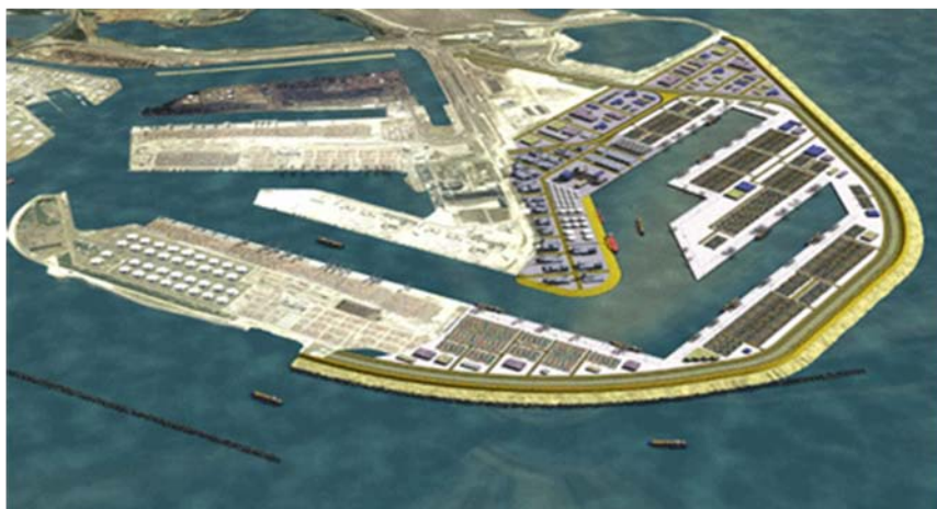
ロッテルダム港拡張計画（マースフラクテIIプロジェクト）
