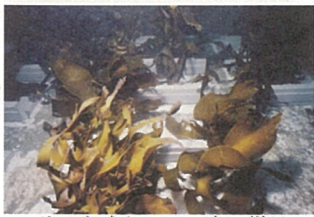
スリット式ケーソン内の様子
