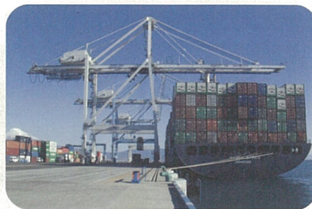
〈-15mの水深を有する 新興津コンテナターミナル〉
