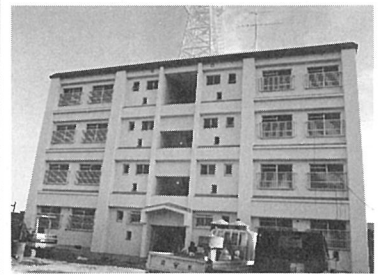
▲完成した駒越北宿舎
