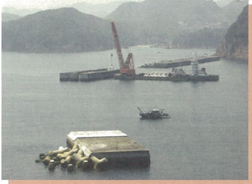
〈下田港の防波堤工事の様子〉
