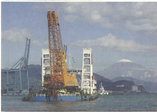
〈クラブ船による浚渫状況〉
