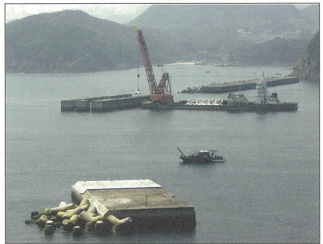
▲下田港：防波堤(西)の双胴型ケーソン内部に消波ブロックを据付ける様子 手前は防波堤(東)
