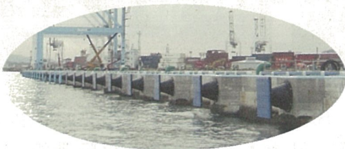
〈色彩計画に基づいた色で塗られた-15m岸壁〉
