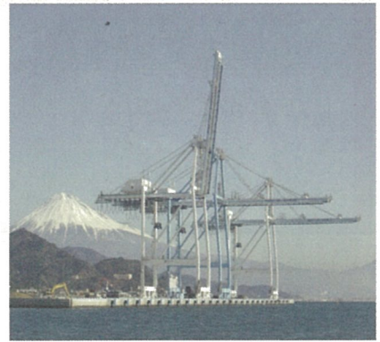
〈新興津岸壁に設置されたスーパーガントリークレーン〉
