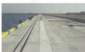
〈耐震構造の岸壁〉
