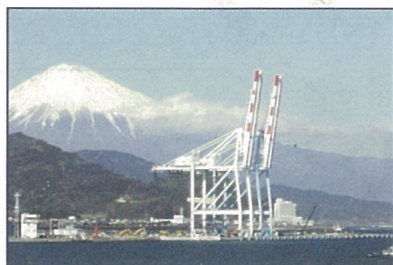
〈新興津岸壁に設置されたガントリークレーン〉
