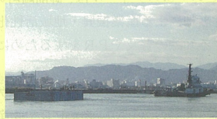
③ワイヤーで引っ張りながら 一晩かけて御前崎港へ
