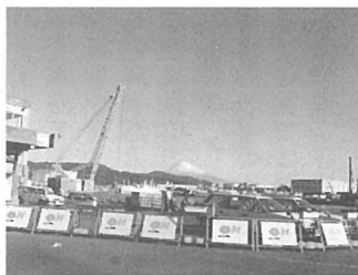
▲イメージアップされた清水港江尻岸壁の作業現場
