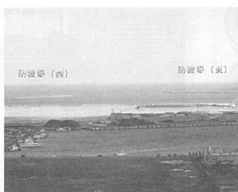
▲建設が進む御前崎港防波堤(西)
