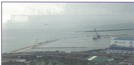
<新興津コンテナターミナル工事現場>
