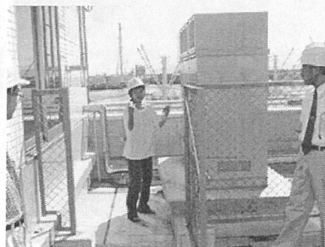
〔非常電源装置の説明〕
