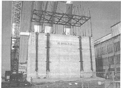
ケーソン吊り上げ状況
