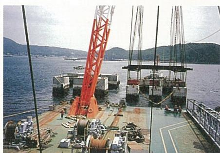
同第2函目ケーランが据付られました。当初予定の6月10日がシケのため中止となり、天候回復を待つていてものです。当日の作業は早朝より実施され、まず、2,200トン吊り起重機船に仮置ケーランが固定され、ケーラン内の海水が排水されました。排水が終わり浮上したケーランを起重機船にて吊し防波堤まで曳航、既に据付られている第1函目ケーランに沿つて第2函目ケーランが設置されました。テレビや新聞等の報道機関が多数見守るなか、無事作業が終了し工事関係者一同ほっと胸をなで下ろしました。
