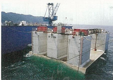
て FD に海水を注入して沈めると、FD に置かれていたケーラー ソンがボツカリと浮上しました。浮上したケーラー ソンを起重機船にて吊し、港内のケーラー ソン仮置場まで曳航し仮置きの一連の作業も無事終了しました。3 函目のケーラー ソンとあつて、工事関係者は作業にも慣れ、予定の時間より早く終了したことから、当日取材にきた報道関係者もその手際の良さに感心するなど、工事関係者全員の明るい笑顔が印象的でした。
