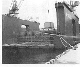
▲フローティングドックの上で製作中のケーソン
