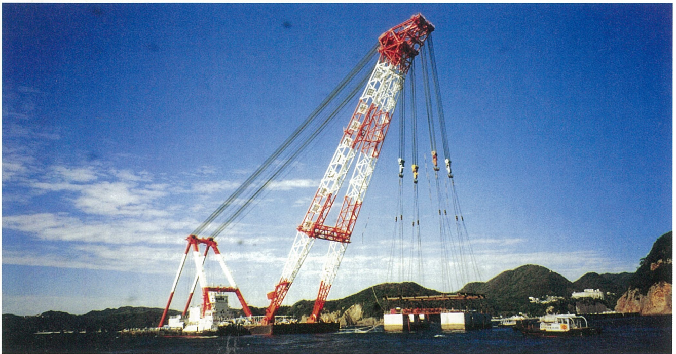
下田港双胴型ケーソン据付風景
