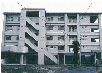
完成した駒越北宿舎B棟
