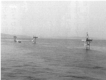
岸壁 - 14mの土質調査状況
