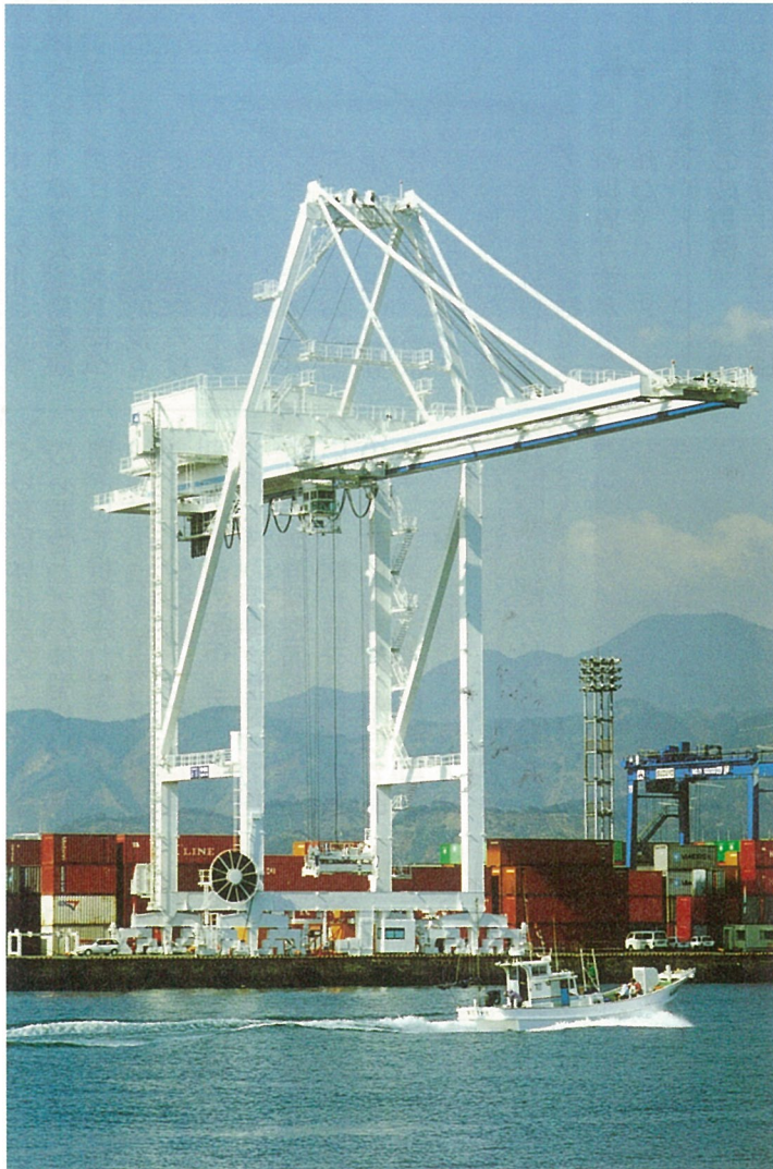
スーパーコンテナクレーン（袖師第一埠頭）
