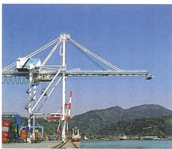
コンテナクレーン (袖師埠頭)
