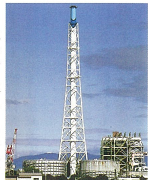
中部電力の煙突
