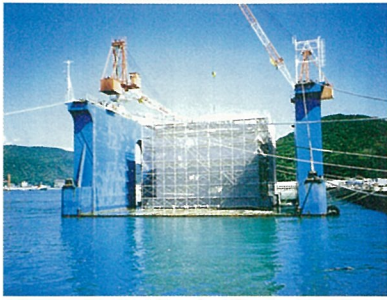
フローティングドックで製作中のケーソン (下田港内)
