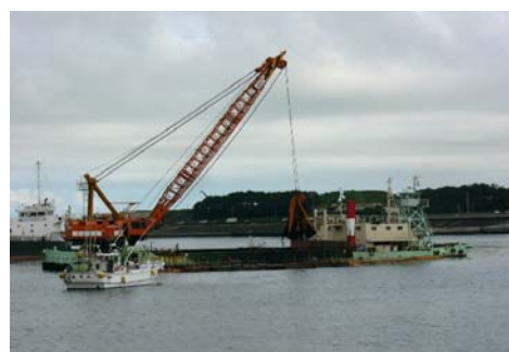
航路・泊地の浚渫工事
