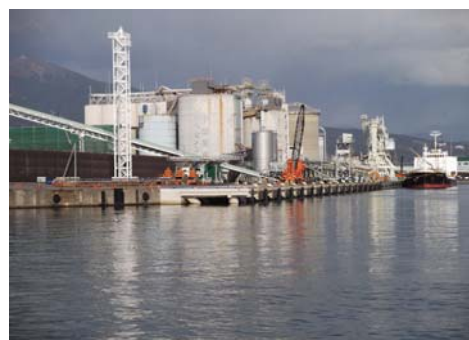
完成した中央地区国際物流ターミナル
