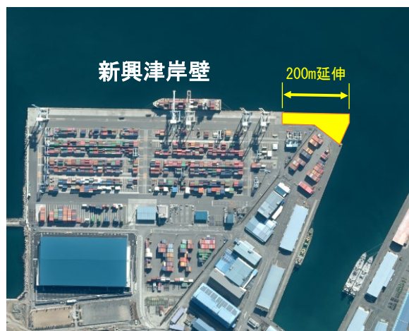
<新興津岸壁延伸事業の概要>
