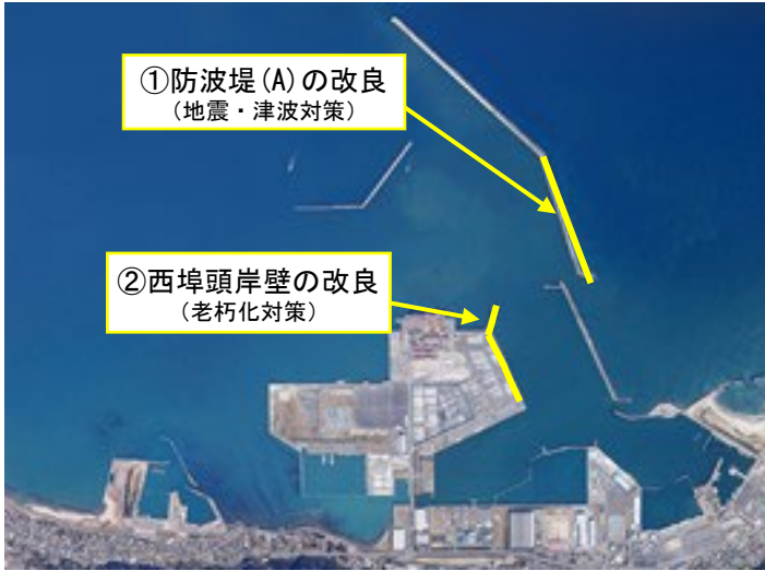
<御前崎港の事業箇所>
