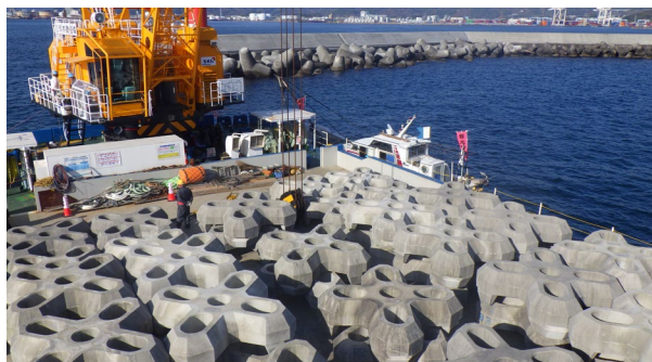
外港防波堤 被覆ブロックの設置(R8.1)
