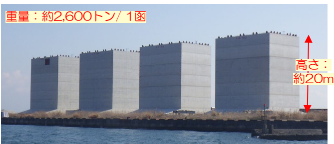
新興津岸壁延伸部に据え付けるケーソン (R8.3)
