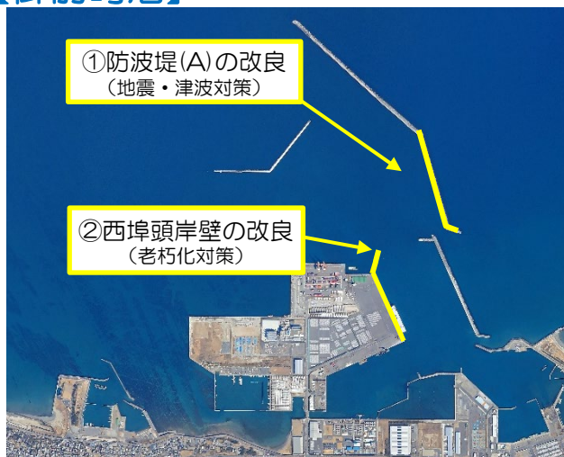
＜御前崎港の事業箇所＞
