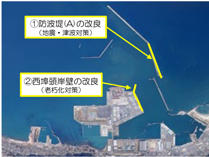
<御前崎港の事業箇所>
