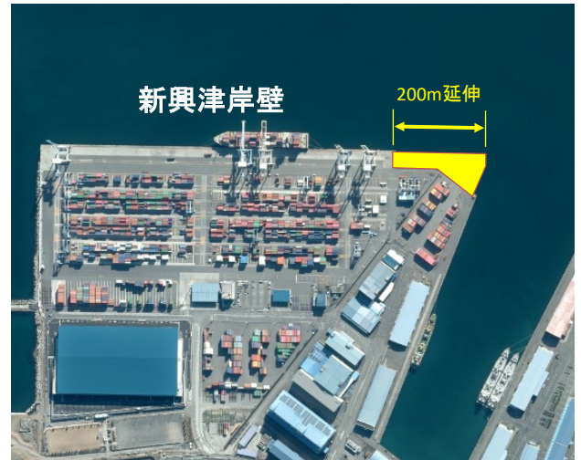
<新興津岸壁延伸事業の概要>
