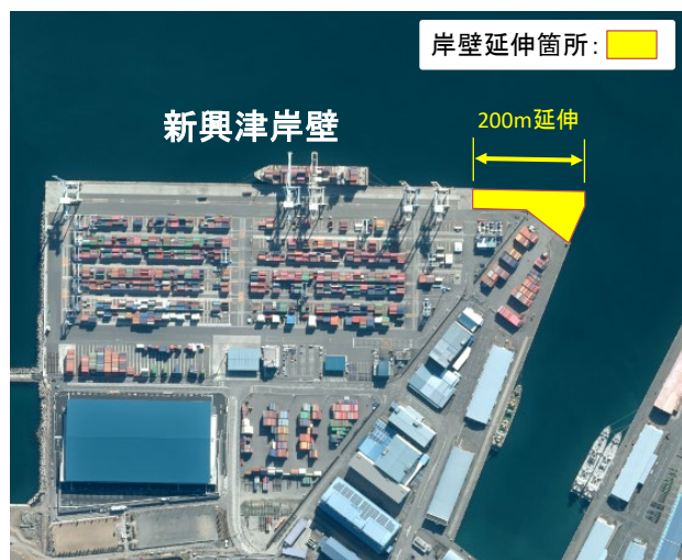
<新興津岸壁延伸事業の概要>
