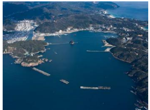
下田港 (地方港湾・避難港)
