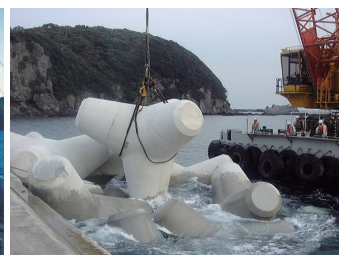
80t型高比重消波ブロックの据付作業 (2002年10月)
