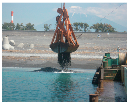
掘削した砂を活用した養浜 (2018年5月)
