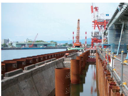
鋼管杭の打設工事 (2007年4月)
