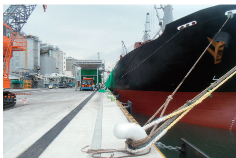
改良工事完成後の中央2号岸壁 (2011年6月)
