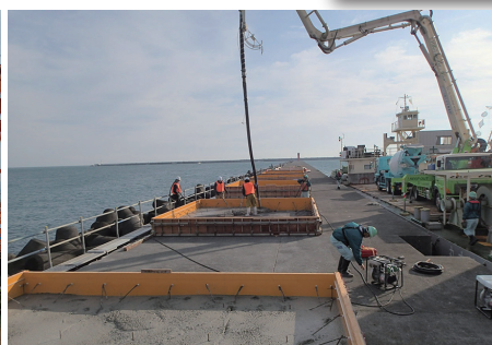
防波堤(西) 上部工の高上げ工事 (2017年11月)
