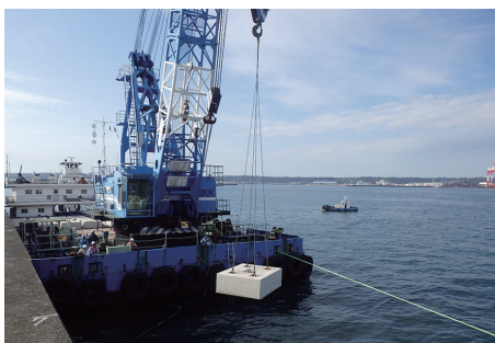
防波堤(東) 根固ブロックの据付作業 (2018年11月)
