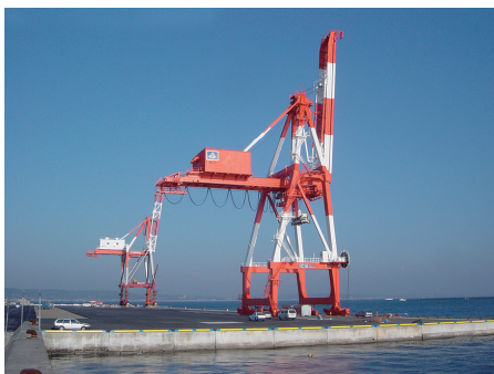
完成後の西埠頭10号岸壁 (2003年12月)
