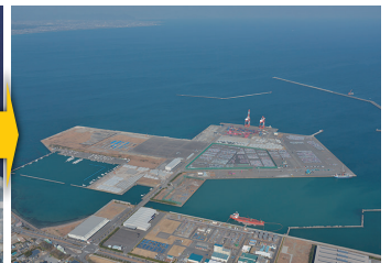
現在の御前崎港西埠頭 (2021年2月)
