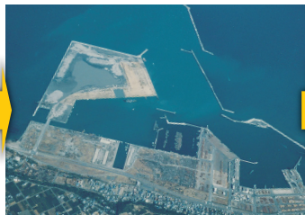
西埠頭1~2号岸壁完成時 (1985年1月)
