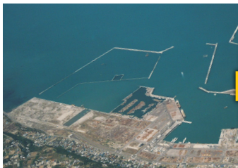
工事中の御前崎港西埠頭 (1979年4月)
