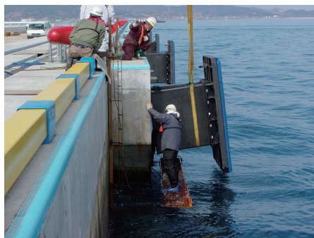
岸壁への防舷材の取付作業 (2003年1月)
