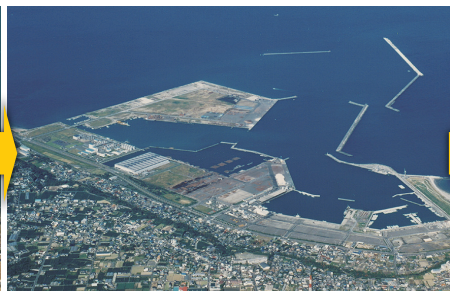
防波堤（東）・（西）工事中の御前崎港 (1996年)
