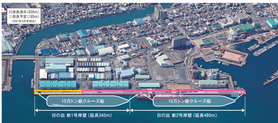
日の出岸壁の改良状況
