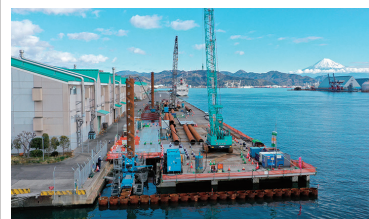
鋼管杭の打設工事(回転圧入工法) (2020年2月)
