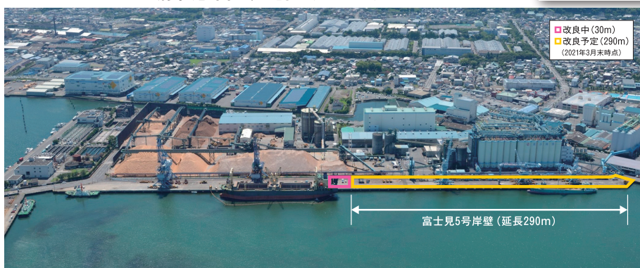
富士見岸壁の改良状況
