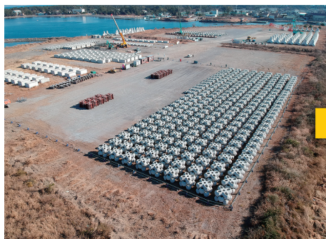
被覆ブロックの製作状況 (2021年1月)
