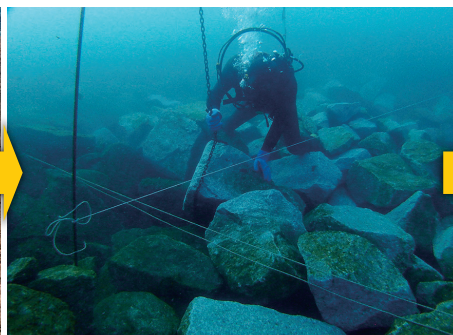
潜水士による石材の均し作業 (2021年1月)
