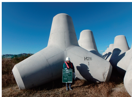
80t型消波ブロックの製作状況 (2017年1月)
