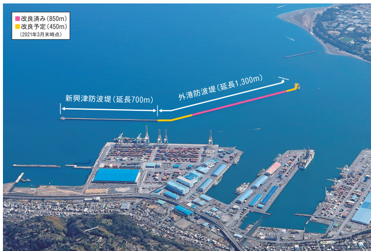
防波堤の改良状況
