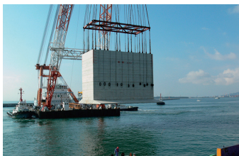
岸壁本体(ハイブリッドケーソン)の据付作業 (2010年8月)
