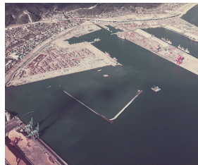
工事中の袖師第1埠頭 (1973年)
