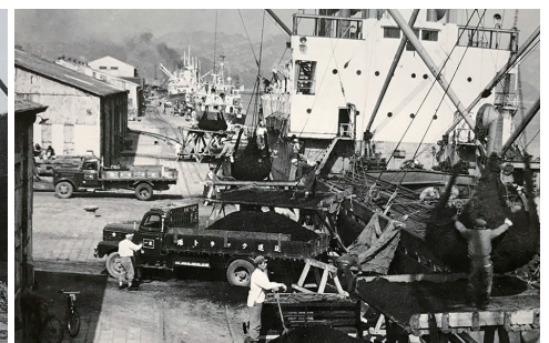
日の出岸壁における石炭の荷揚げ(1955年)
