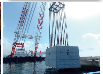
防波堤開口部(航路部)の方塊据付作業 (2016年7月)
