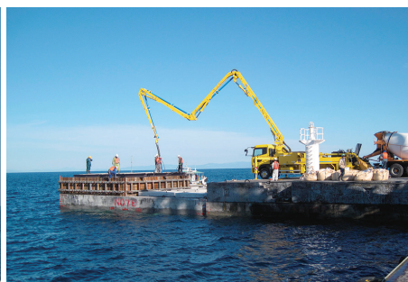
防波堤(東) 上部コンクリートの打設工事 (2014年1月)
