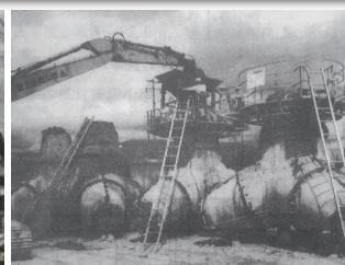
外港防波堤 40t型消波ブロックの製作工事 (1979年)
