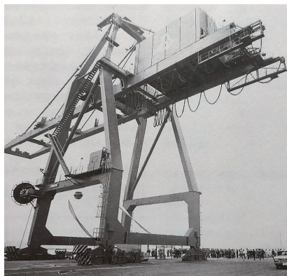
興津12号岸壁に、清水港で初めてコンテナ荷役用ガントリークレーンを設置 (1970年6月)
