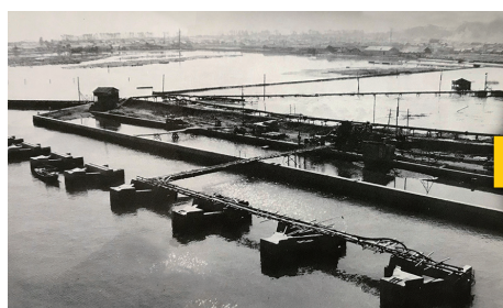
工事中の石炭岸壁 (1955年)
