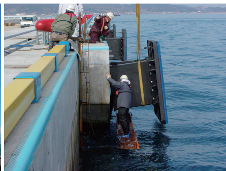
岸壁への防舷材の取付作業 (2003年1月)
