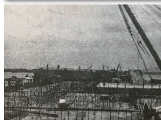
三保防波堤 ケーソンの据付作業 (1973年)
