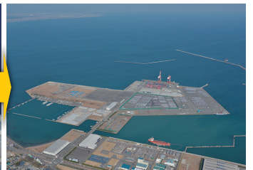
現在の御前崎港西埠頭 (2021年2月)
