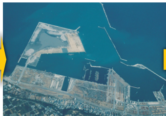
西埠頭1～2号岸壁完成時 (1985年1月)
