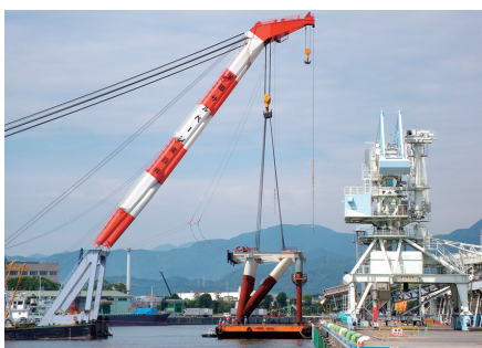
岸壁本体(ジャケット式栈橋)の据付作業 (2009年8月)
