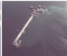
ケーソンの据付作業 (1973年)
