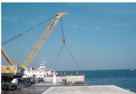
防波堤(東) ケーソンの据付作業 (2014年1月)
