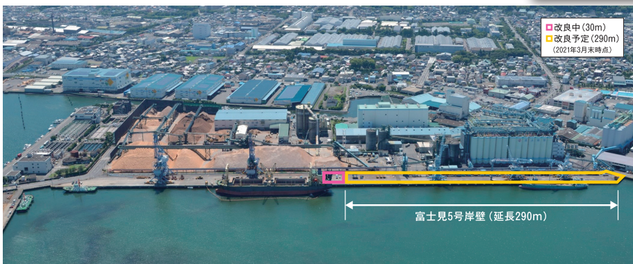
富士見岸壁の改良状況
