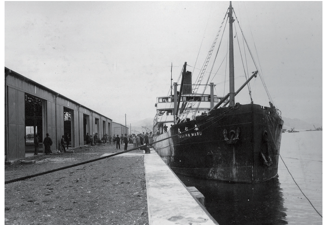
清水港丙岸壁(現・日の出1~2号岸壁)に第1船が入港(初の接岸荷役) (1929年)
