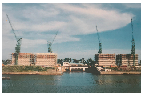
ケーソン4函の同時製作工事 (1983年3月)
