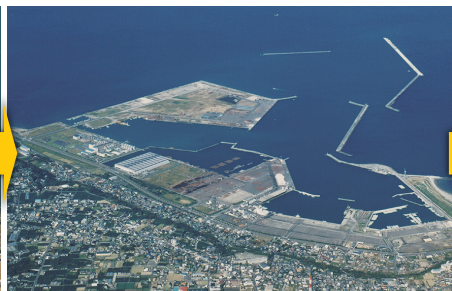
防波堤(東)・(西)工事中の御前崎港 (1996年)
