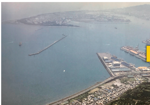
新興津コンテナターミナル整備前 (1994年4月)
