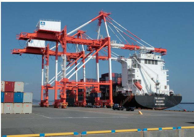
御前崎港 西埠頭10号岸壁 (2021年3月)
