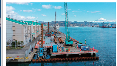
鋼管杭の打設工事(回転圧入工法) (2020年2月)
