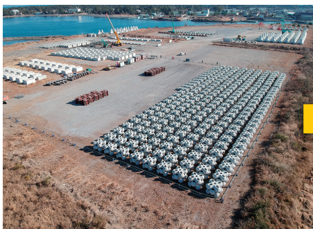
被覆ブロックの製作状況 (2021年1月)
