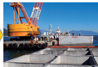
⑤所定位置で据付
