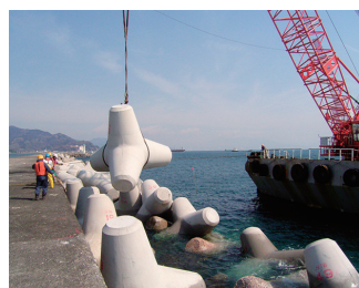
外港防波堤 40t型消波ブロックの据付作業 (2005年3月)
