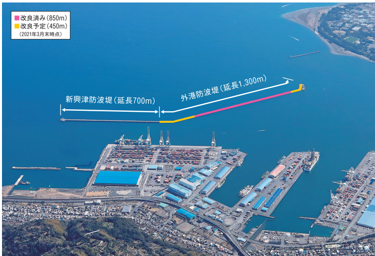
防波堤の改良状況
