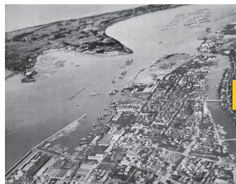
修築工事中の清水港 (1924年)
