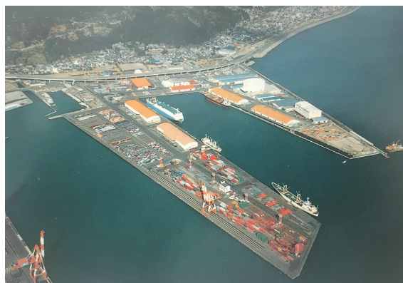
完成後の興津第2埠頭 (1983年)
