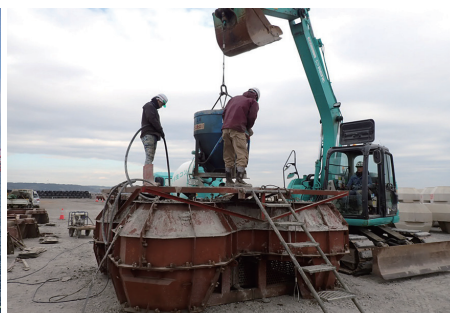
防波堤(東) 16t型被覆ブロックの製作工事 (2020年12月)
