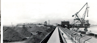
石炭岸壁と貯炭場 (1960年)
