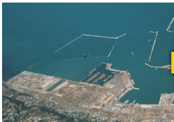
工事中の御前崎港西埠頭 (1979年4月)
