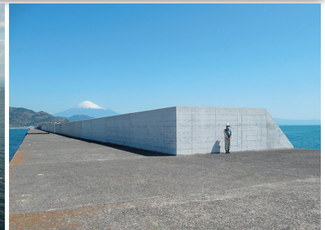
上部工の高上げ後 (2021年4月)
