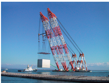
岸壁本体（ケーソン）の据付作業 (2001年11月)
