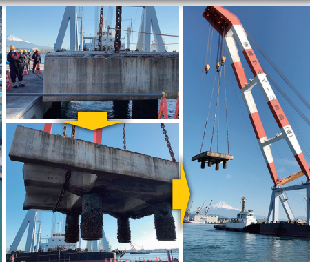
大型起重機船による既設岸壁上部の撤去作業 (2021年1月)
