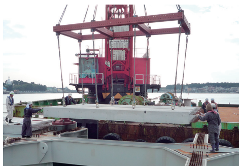
岸壁床版の設置作業 (2008年11月)
