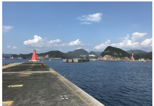
下田港 防波堤 (2020年10月)
