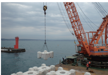
防波堤(西) 30t型被覆ブロックの据付作業 (2016年2月)
