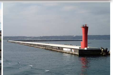
防波堤(西) 上部工の高上げ後 (2018年1月)
