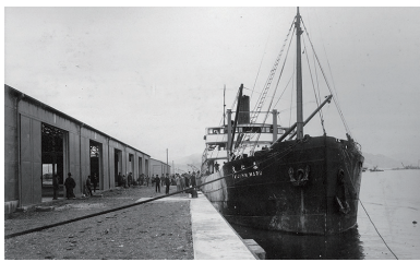
丙岸壁に第1船「泰仁丸」が入港(初の接岸荷役) (1929年5月)
