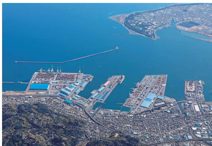
清水港 外港防波堤・三保防波堤 (2021年3月)
