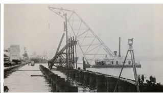
村松岸壁 鋼管杭の打設工事 (1962年)
