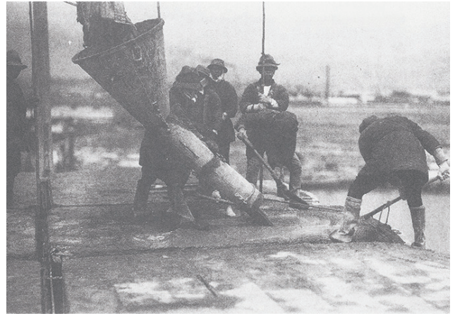
岸壁ケーソンの製作工事 (1924年)
