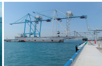
岸壁へのガントリークレーン設置作業 (2013年3月)
