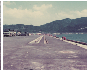
完成後の袖師第1埠頭8号岸壁 (1978年7月)
