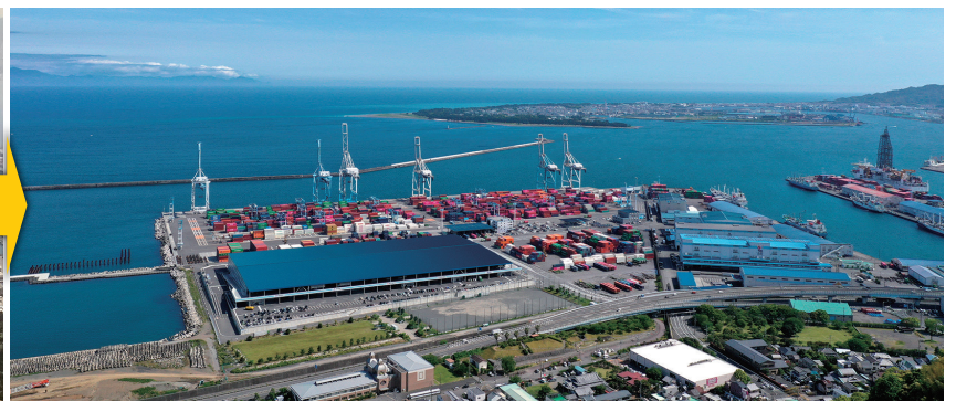
現在の新興津コンテナターミナル (2021年5月)
