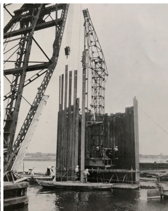
石炭岸壁 円筒脚柱の鋼板打設工事 (1956年)
