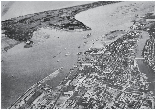
第二期修築工事中の清水港 (1924年)
