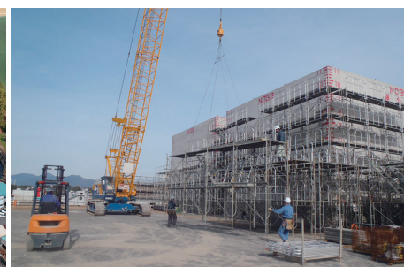
清水港新興津防波堤本体ケーソン(約1,600t)の製作工事 (2013年1月)
