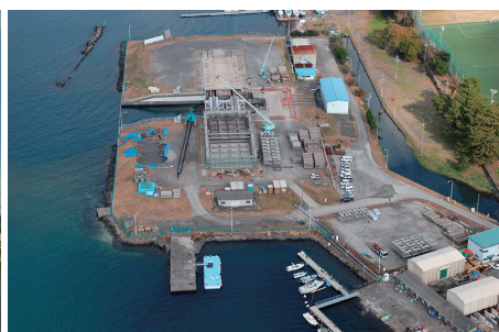
三保ケーソン製作場の全景 (2008年12月)
