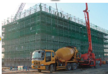
②コンクリートの打設
